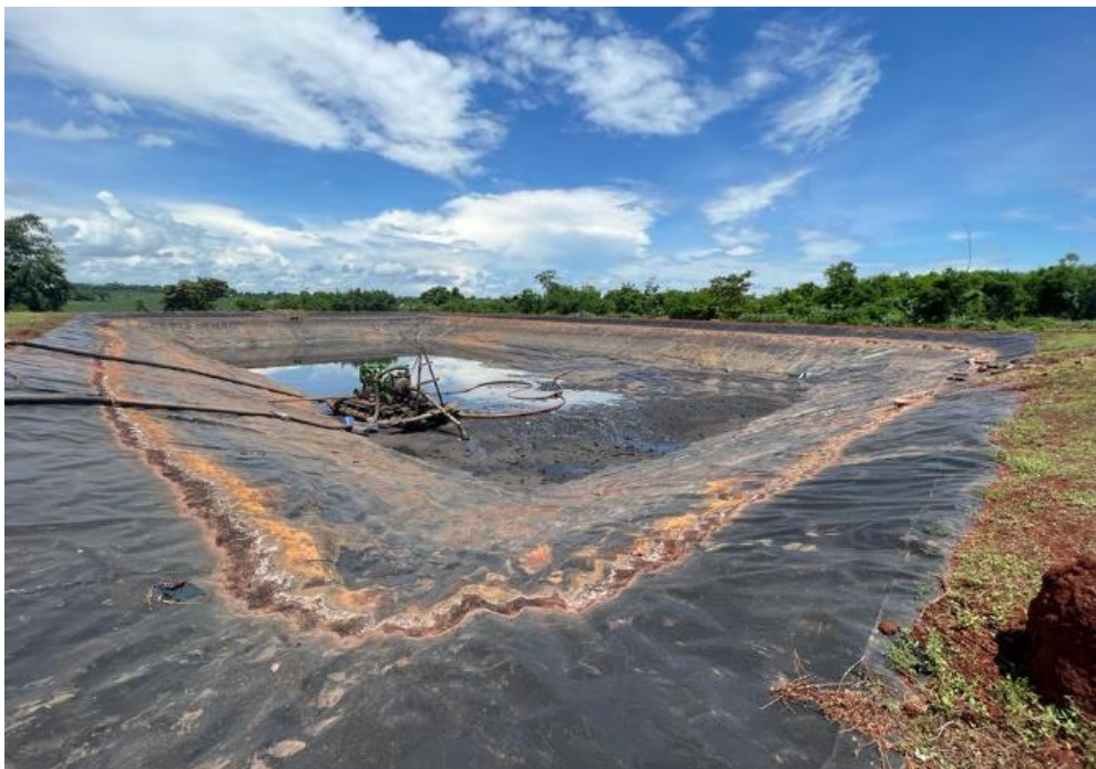
Imagem 04 - Conclusão da dragagem da Lagoa Anaeróbia 02
