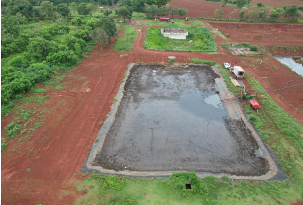
Imagem 01 – imagem área da Lagoa Anaeróbia 01.
