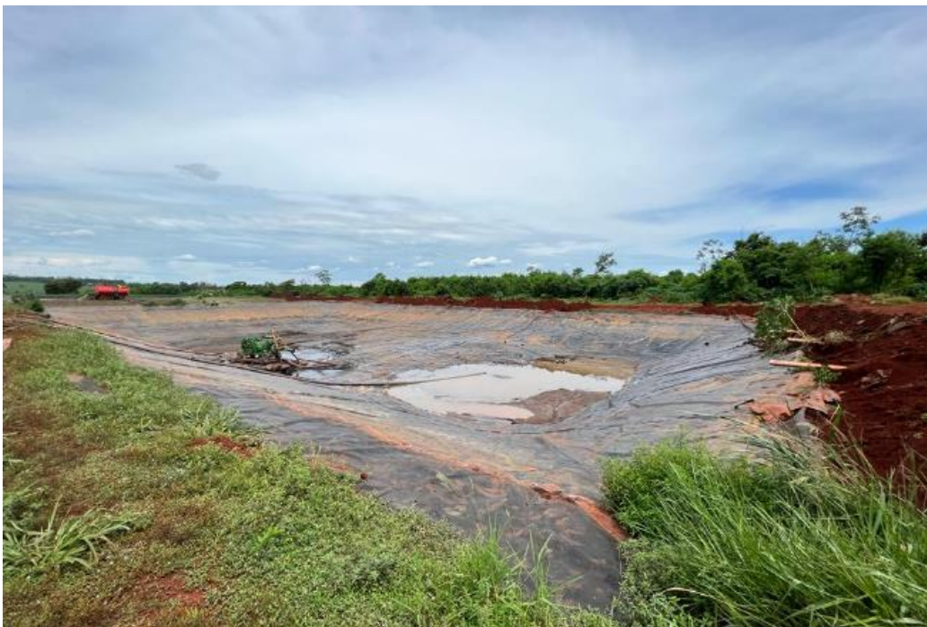
Imagem 02 – Conclusão da dragagem da Lagoa Anaeróbia 01
