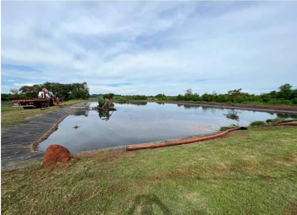
Imagem 03 – Início da dragagem da Lagoa Anaeróbia 02
