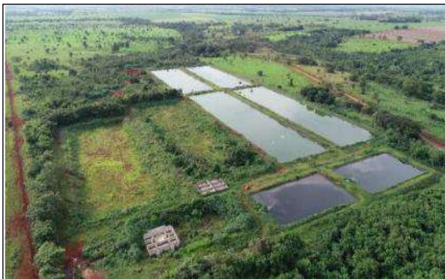
Figura 22 - Estação de Tratamento de Esgoto - ETE Ararão.
