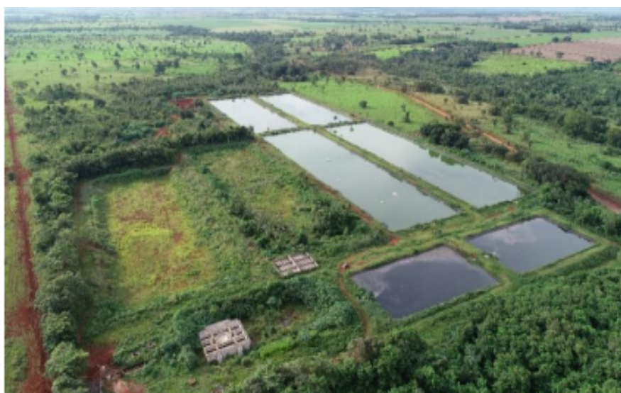
Figura 22 - Estação de Tratamento de Esgoto - ETE Ararão.
