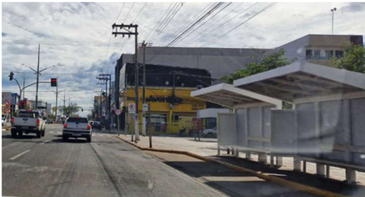
Foto 90: Ausência de padronização dos abrigos (autor – 2024).
