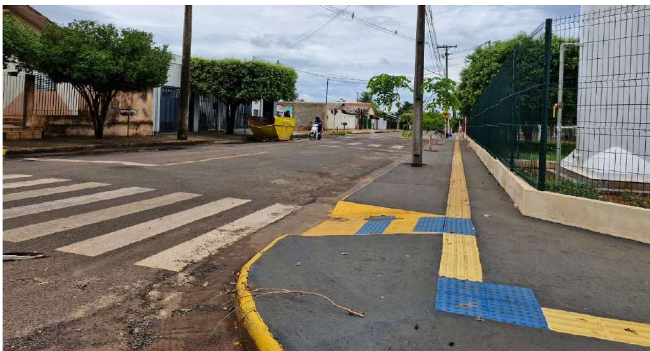
Foto 41 - Novo padrão de acessibilidade sendo adotado em toda cidade (autor – 2024).
