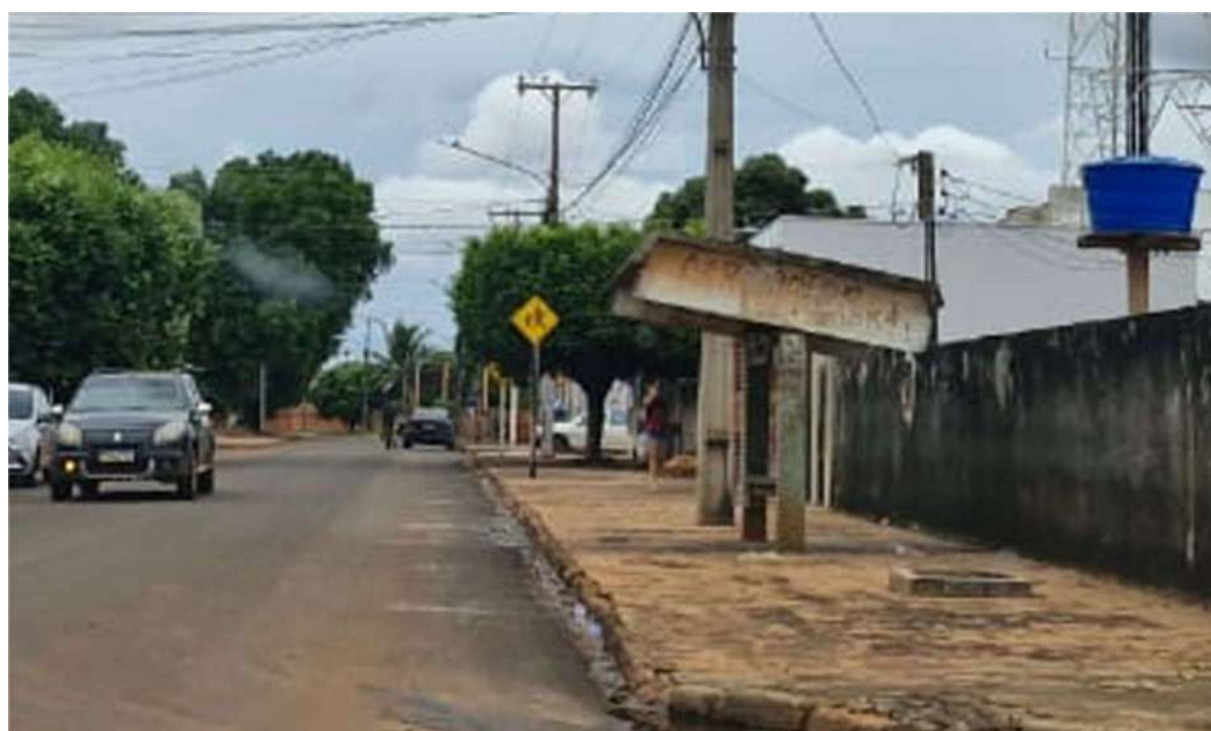
Foto 89: Ausência de padronização dos abrigos (autor – 2024).
