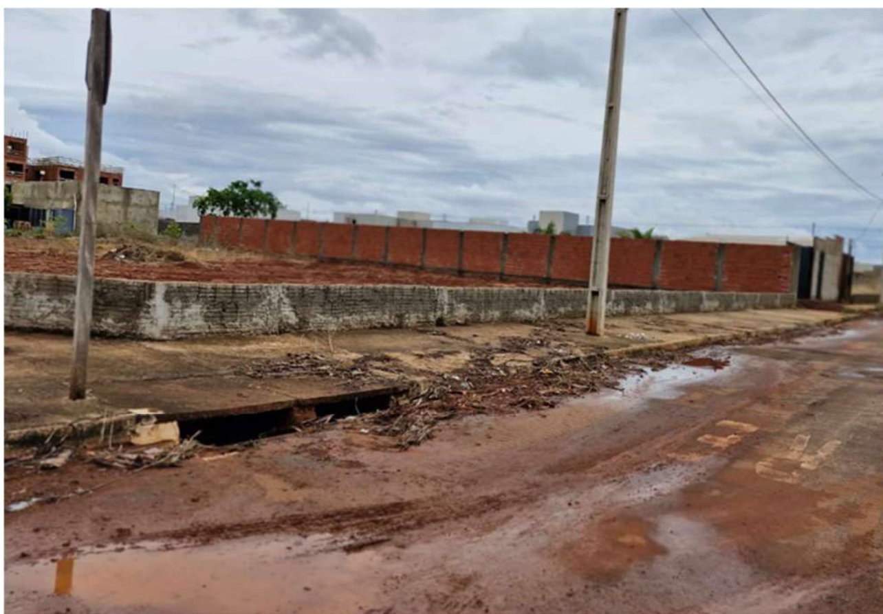
Foto 76: Ausência de escoamento de águas superficiais e acúmulo de sedimentos situação encontrada em diversos locais da cidade (autor – 2024).
