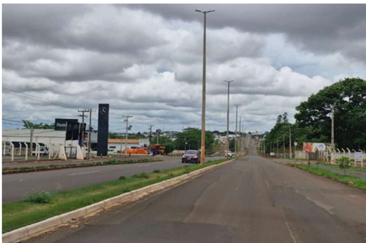
Foto 82: Ausência de ciclovia para acesso aos frigoríficos, no trecho municipal (autor – 2024).
