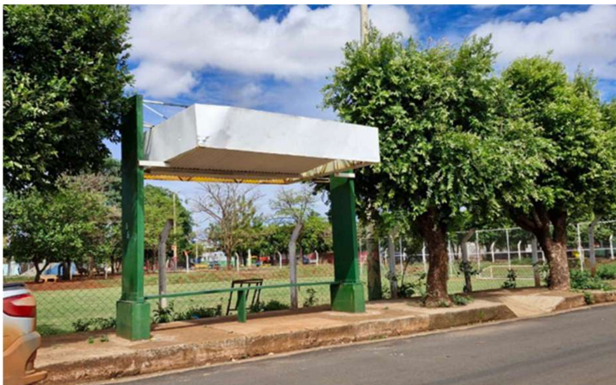
Foto 93: Ausência de padronização dos abrigos (autor – 2024).
