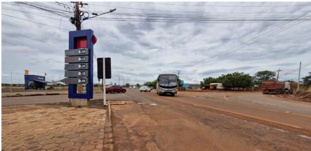
Foto 56: Cruzamento muito perigoso para o qual rotatória aumentaria a situação de segurança viária 9 autor – 2024).
