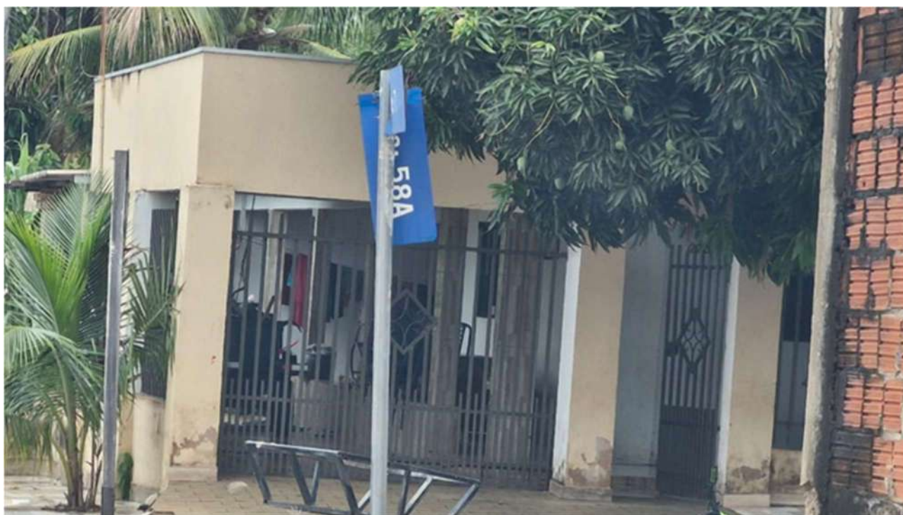
Foto 57: De maneira geral não há placas toponímicas, porém das existentes muitas encontram-se danificadas como a deste exemplo (autor – 2024).
