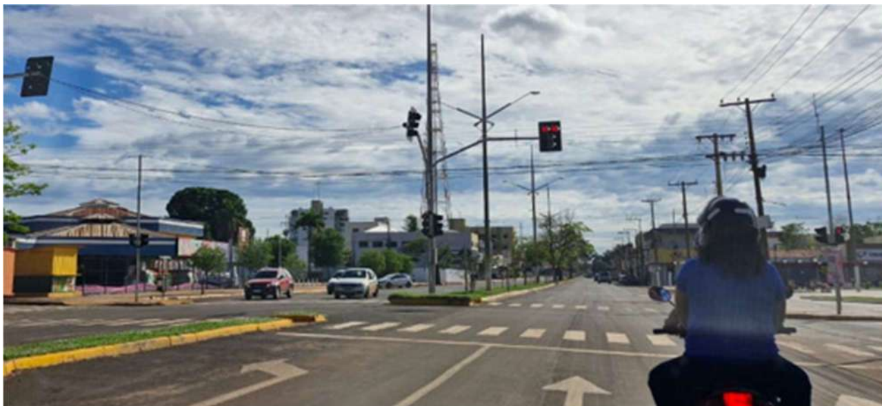
Foto 68: Ausência de foco repetidor, em desacordo com o Manual Brasileiro de Sinalização Semafórica (autor – 2024).
