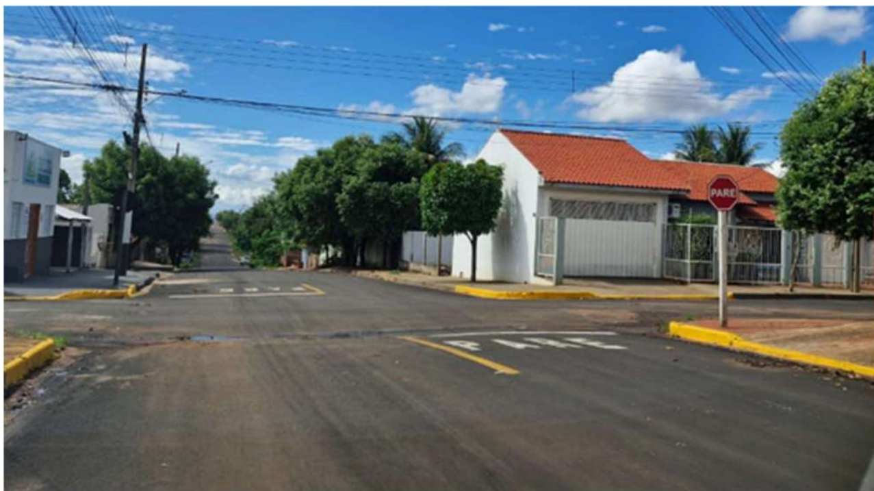
Foto 59: Padrão de sinalização de solo a ser implantado em toda cidade (autor – 2024).
