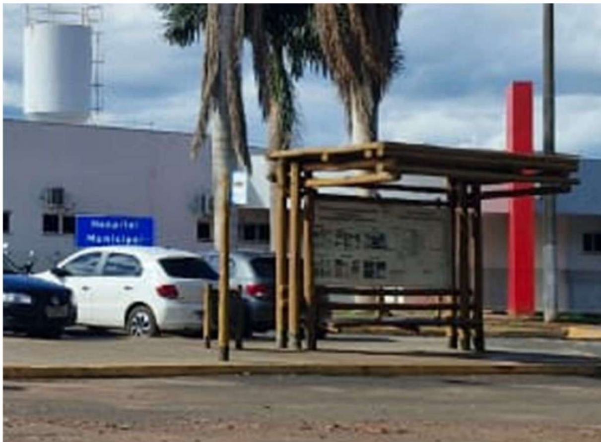
Foto 94: Ausência de padronização dos abrigos (autor – 2024).
