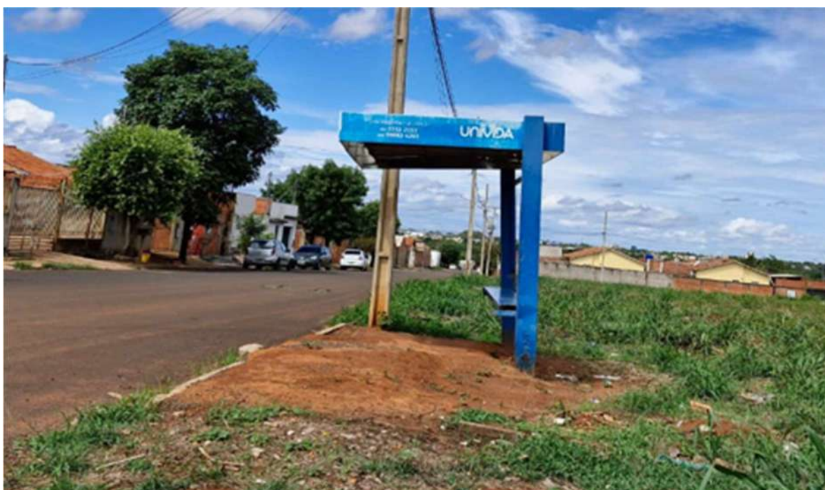
Foto 91: Ausência de padronização dos abrigos (autor – 2024).
