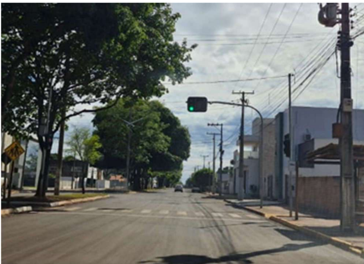
Foto 69: Ausência de foco repetidor e presença de contador não recomendado no o Manual Brasileiro de Sinalização Semafórica (autor – 2024).
