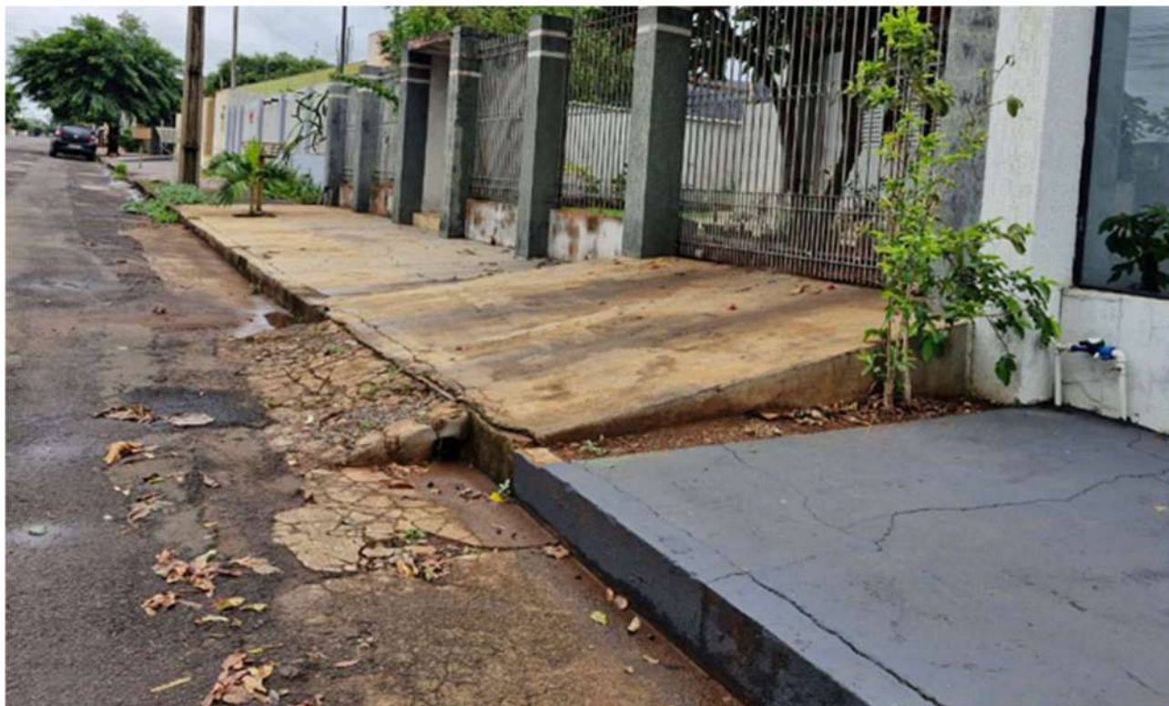
Foto 48: Calçada com uso degrau e rampa ocupando área da sarjeta, situação encontrada em vários pontos da cidade (autor – 2024).
