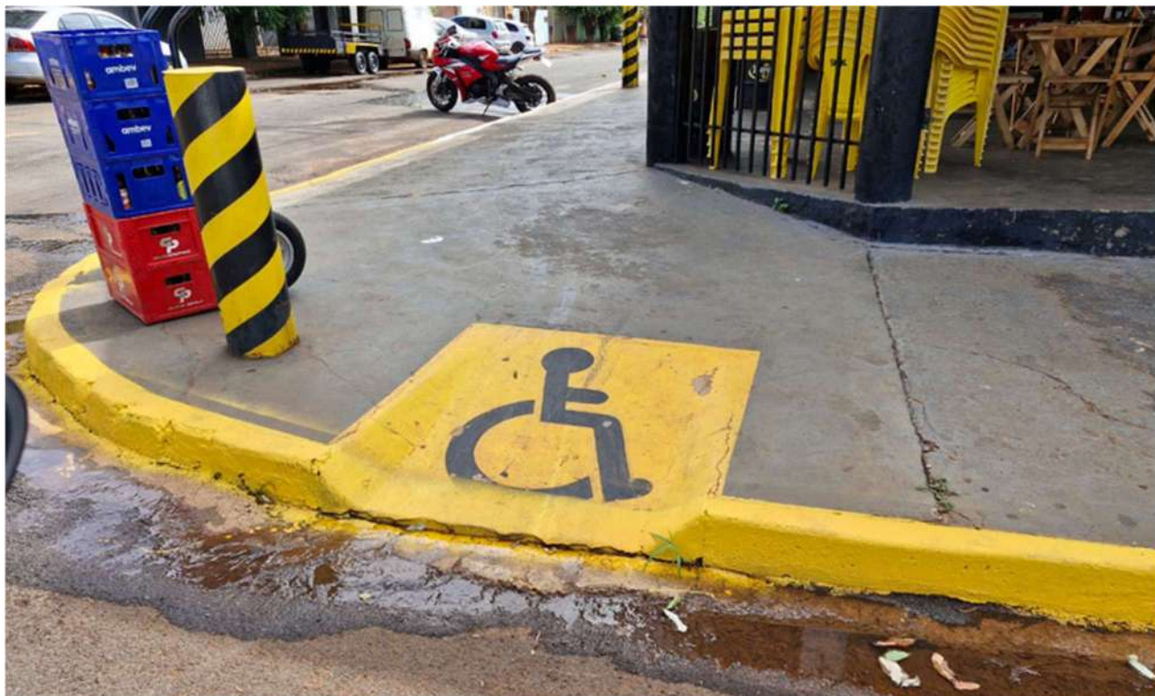
Foto 44: Rampa peculiar, porém fora da Norma NBR 9050 (autor – 2024).
