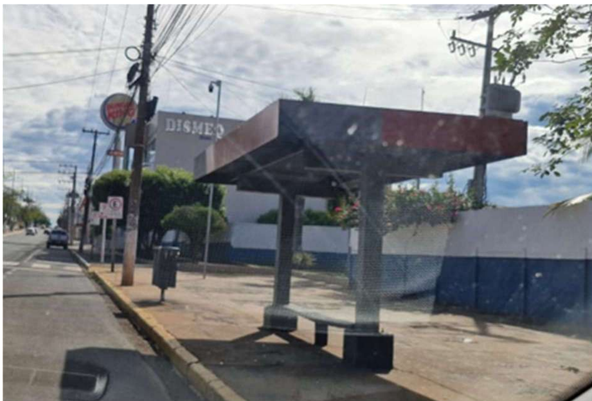
Foto 92: Ausência de padronização dos abrigos (autor – 2024).
