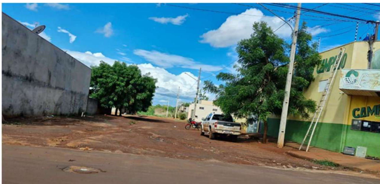
Foto 74: Ausência de pavimento, situação encontrada em diversos locais periféricos (autor – 2024).
