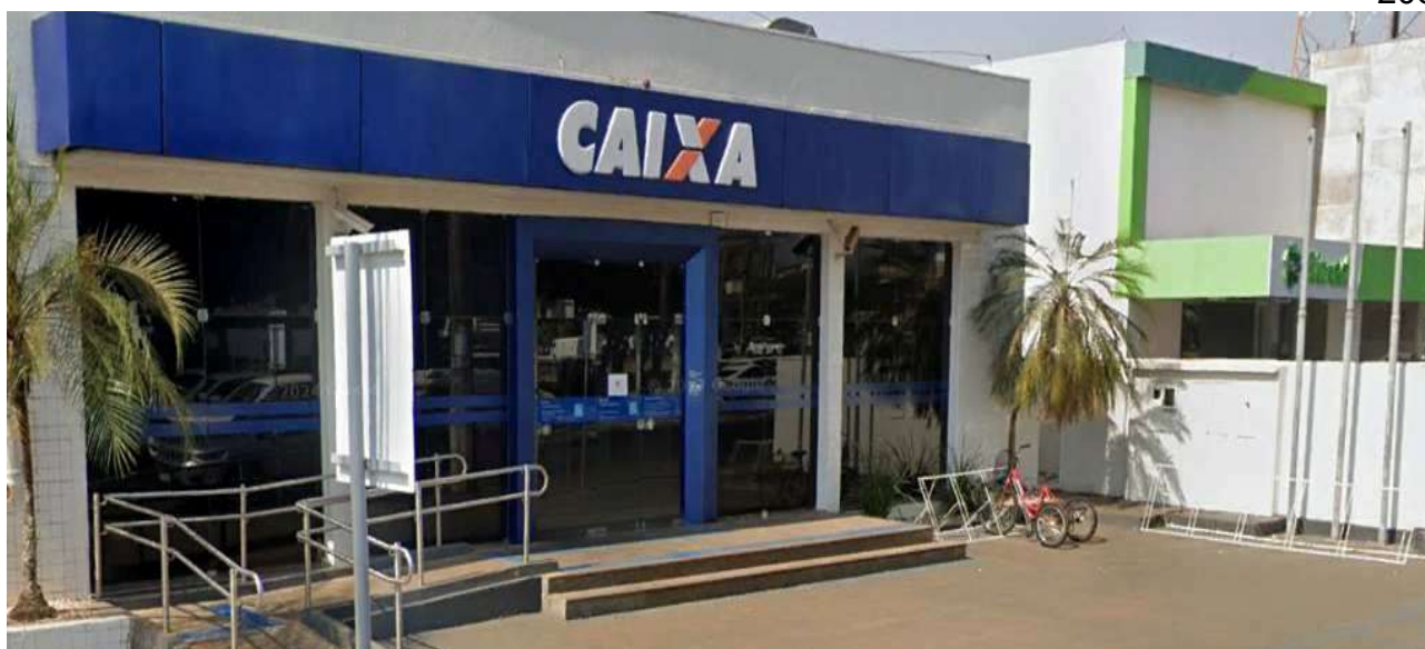
Foto 44– Bicletário Caixa - Tangará da Serra (Google maps 2025).
