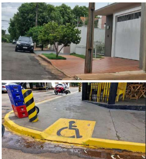
Fotos 17 e 18 – Calçadas e acessibilidade (equipe técnica 2025).
