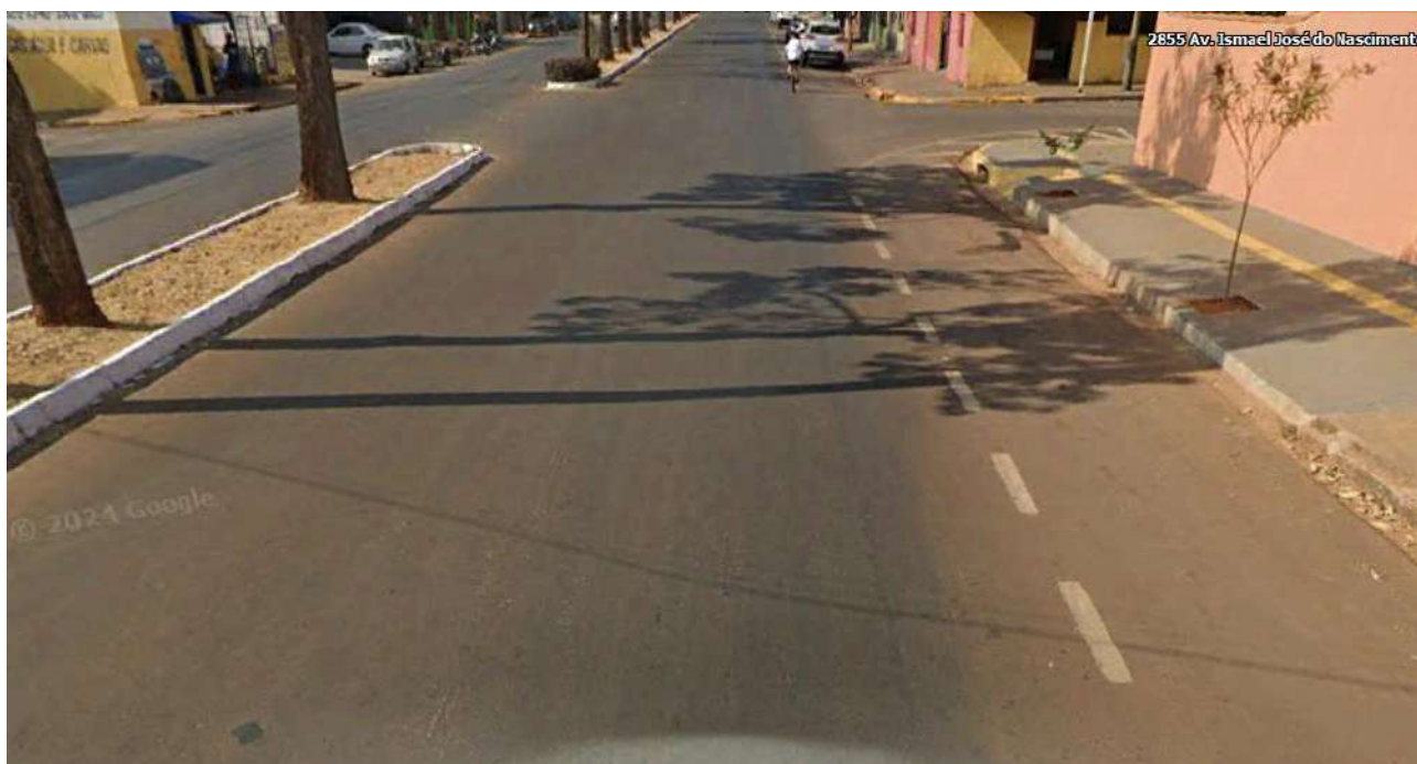
Imagem 24: Trecho típico da Av. Ismael que deverá ter alargamento de 75 cm do canteiro central para cada lado, e ainda receber gradis para proteção dos ciclistas.
