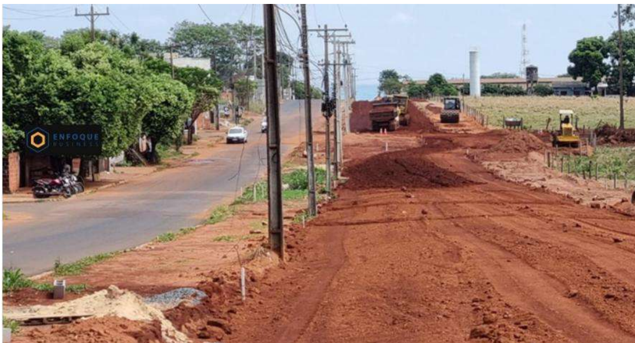
Imagem 35: Obras em andamento da Av. Alvadi Monticelli, para a qual está incluída ligação por ciclovia no canteiro central.
