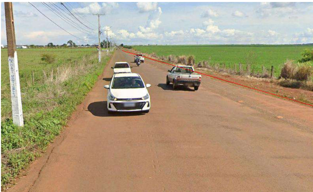
Imagem 32: Ciclofaixa existente necessita de segregação, nova sinalização e iluminação, bem como ser considerada no projeto de transposição do Anel Viário André Antonio Maggi..
