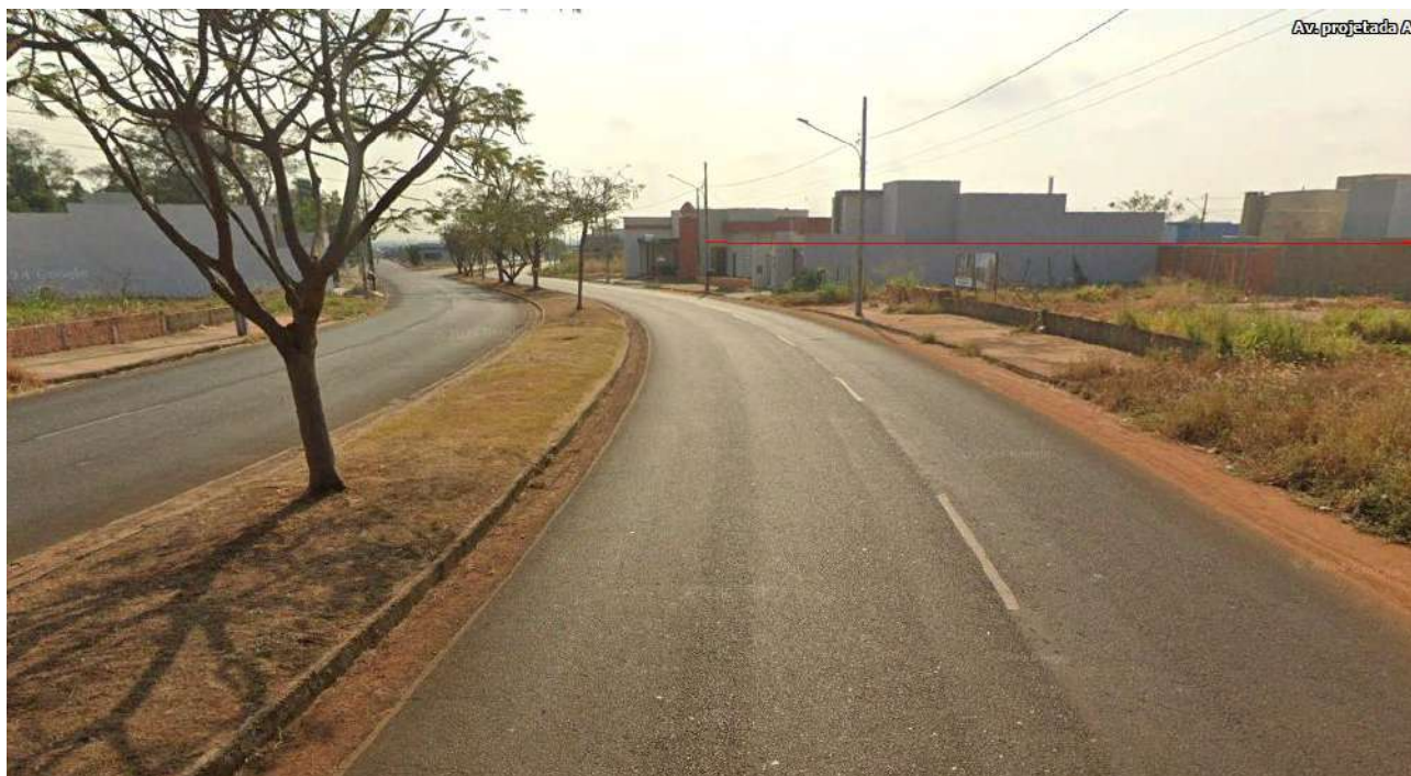
Imagem 59: Ciclovia no canteiro central Av. Projetada A.
